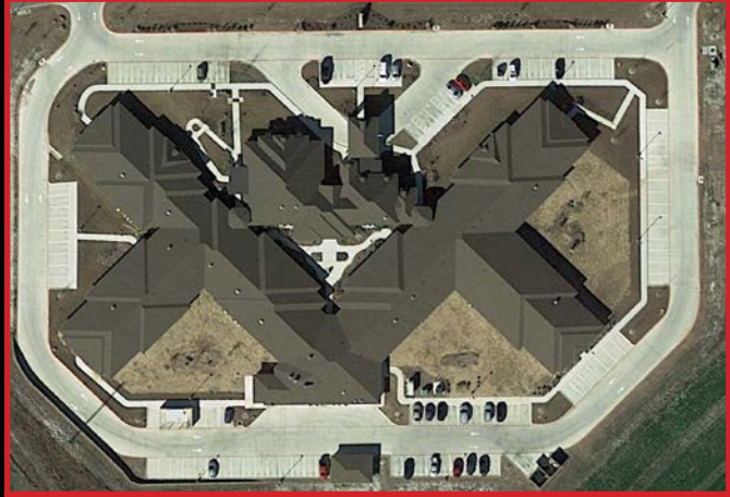
149 Klattenhoff Lane - Hutto - TX
