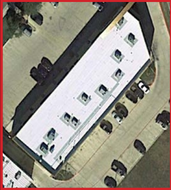
9820 Huebner Rd - San Antonio - TX
